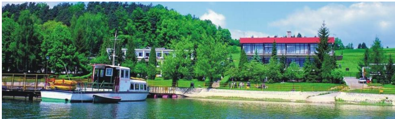
Dom Wczasowy STALOWNIK.
